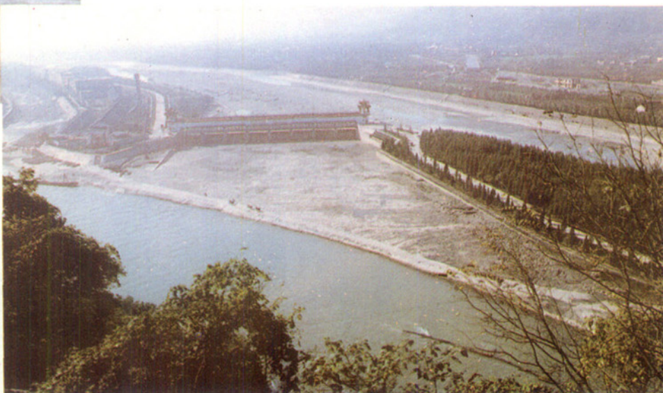
▽ 飞沙堰坝与工业引水拦水闸。
