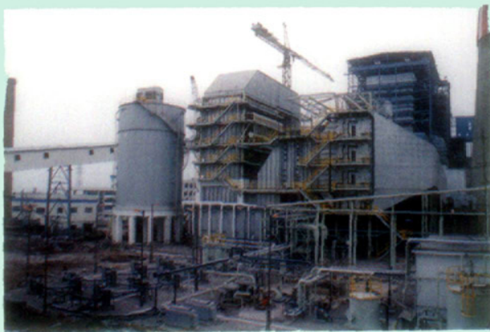
◀ 建设中的珞璜发电厂,是全国首家采用烟气脱硫装置系统的火力发电厂,总装机容量72万千瓦。
