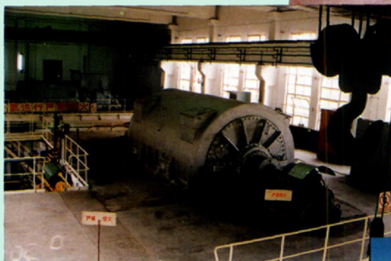
◀四川省最早(1975 年 7 月)建成投产的调相机—重庆盘溪变电站的 3 万千乏调相机
