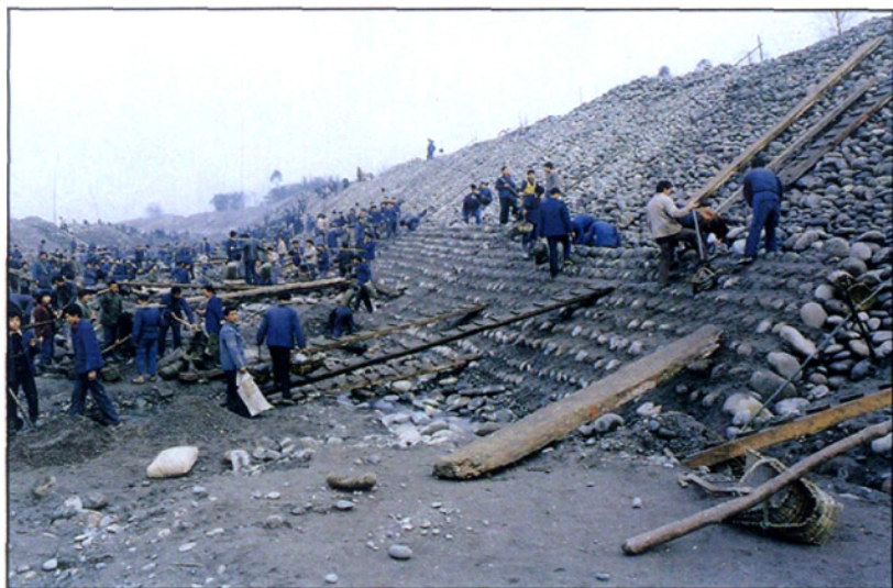
岷江金马河新津段 岁修浆砌卵石护岸防洪大堤
