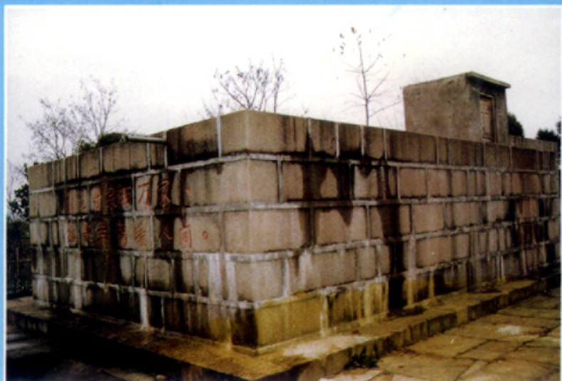
革命老根据地通江县 地处深山，饮水困难，这是 修建的人畜饮水工程。
