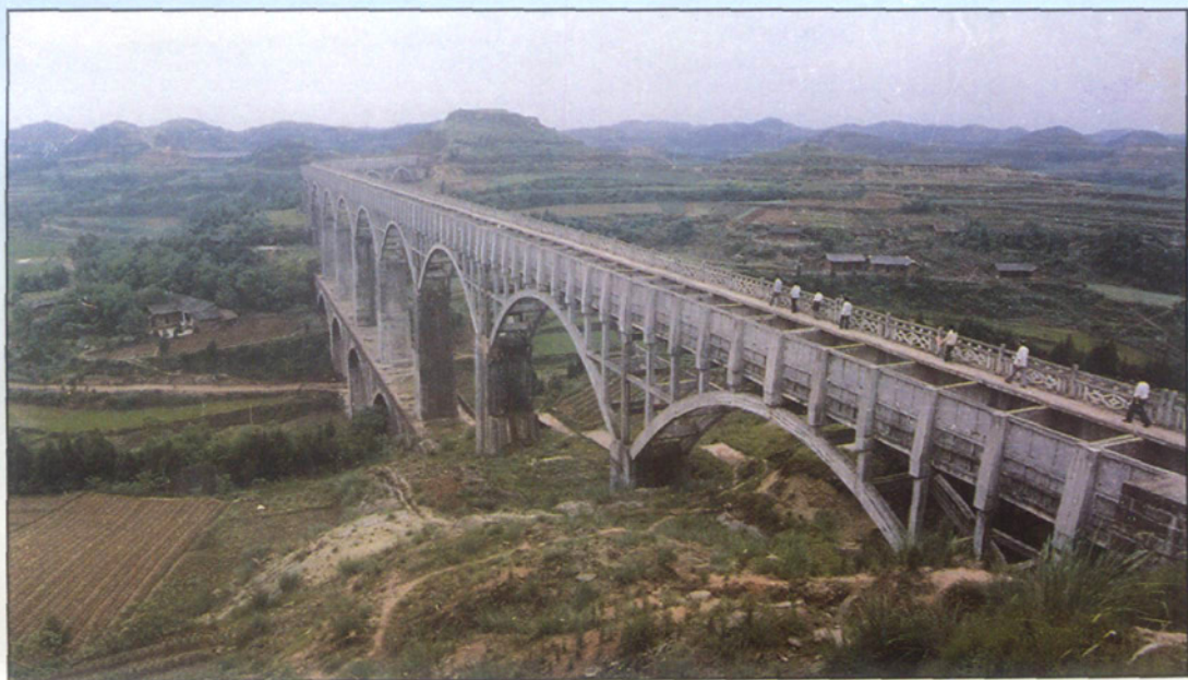
中江县引都江堰水跨邻江上源的双林渡槽
