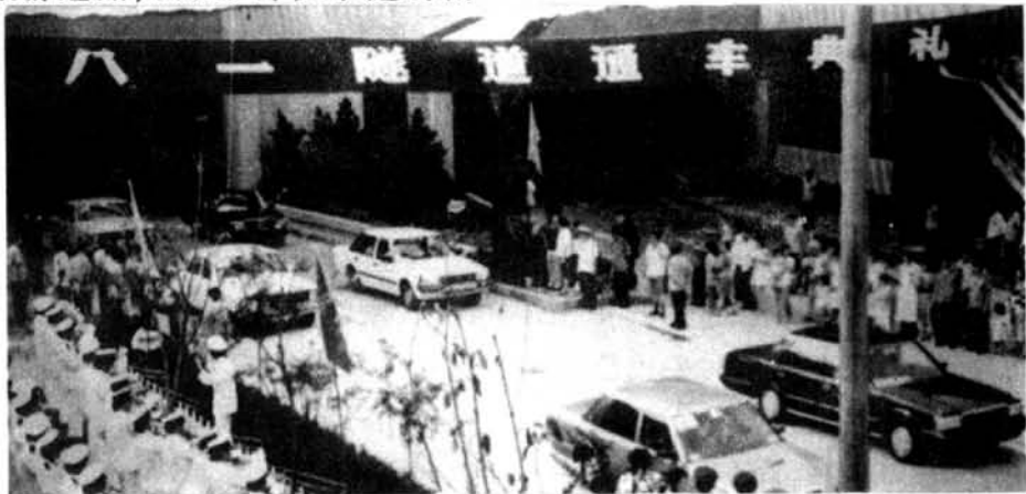
重庆驻军支援地方建设的八一隧道竣工
