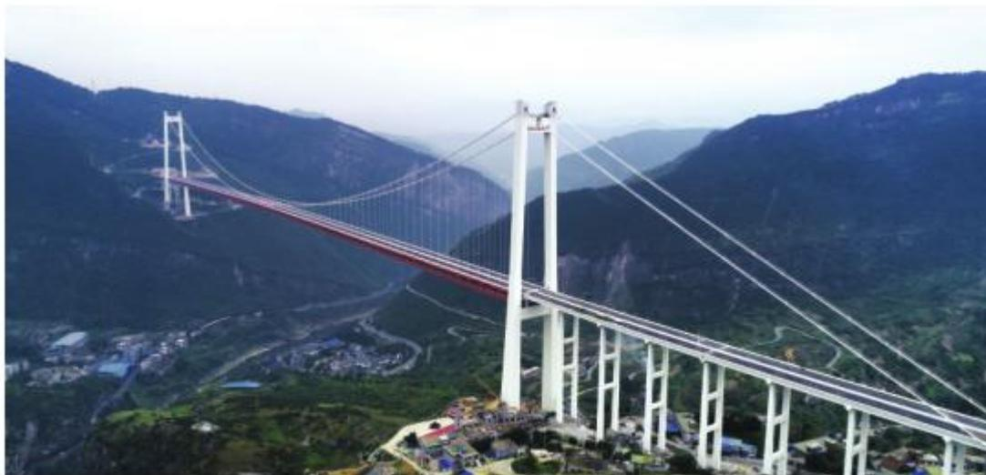
9月30日，川黔大通道古蔺至习水段高速公路赤水河红军大桥建成。大桥全长2009米，主桥为1200米双塔单跨钢桁梁悬索桥
